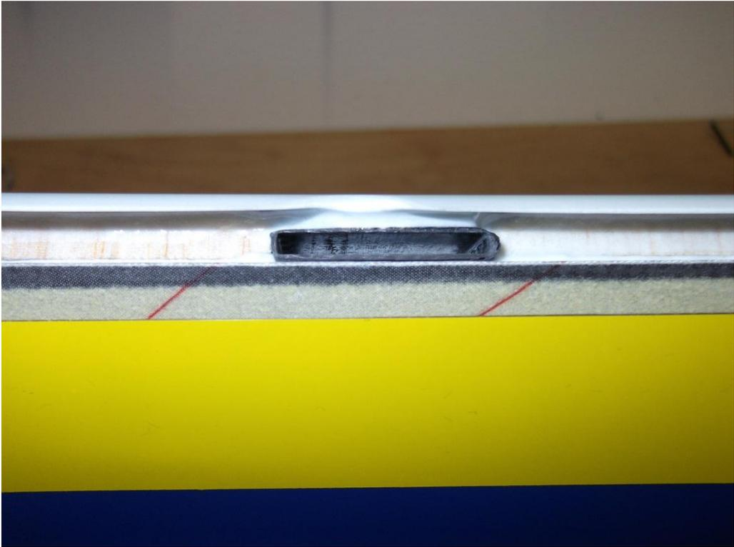
6. Einsetzen des vorbereiteten RDS-Systems zum Einkleben
